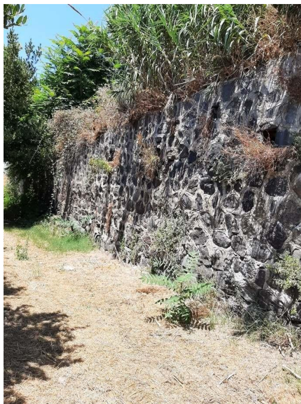
Muro di via Panoramica visto dalla scarpata foto 1
